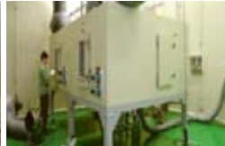
Испытание надежности и ресурса работы оборудования
